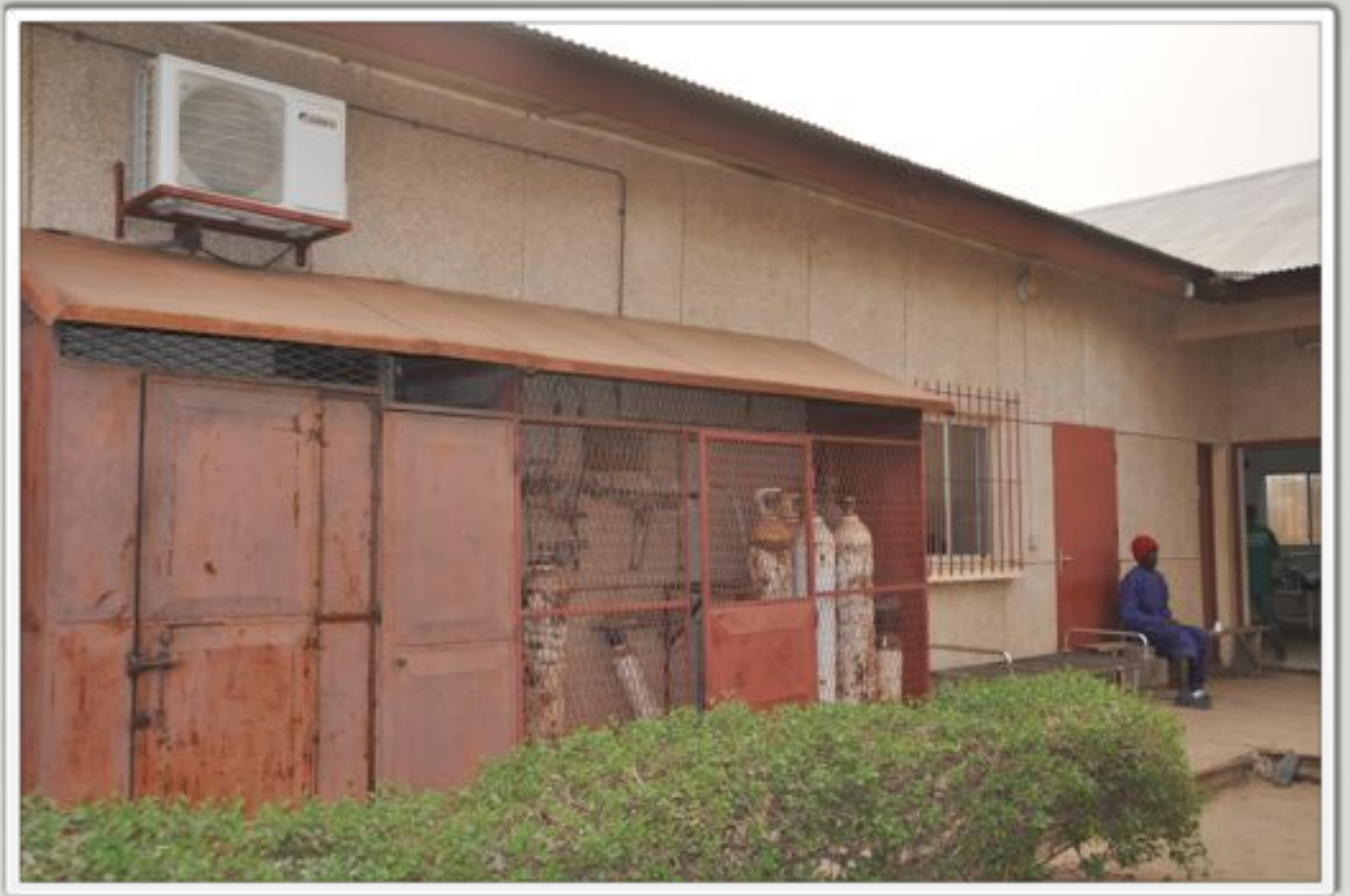
Hôpital de Thiadiaye : le bloc opératoire
