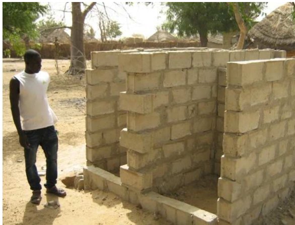
Abbé surveille la construction des toilettes (Photo Thioune)
